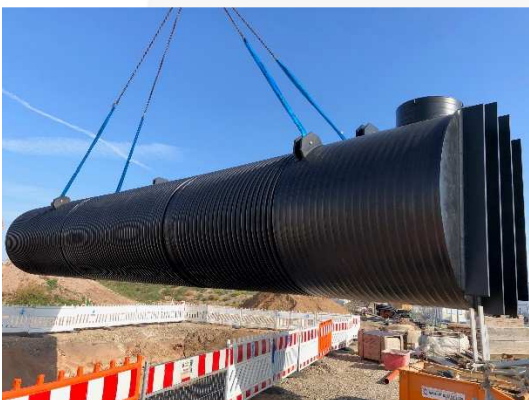
Einheben des ersten Bauteiles
