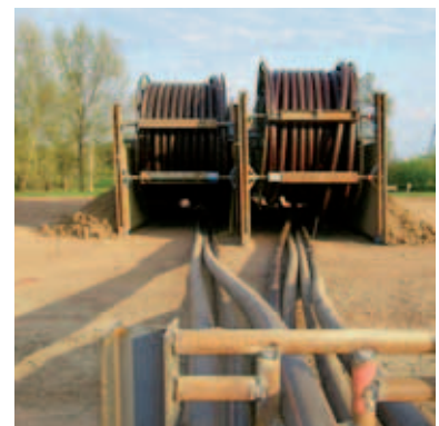
EMDS Schutzrohr in RC-Qualität – Ausführung auf Großtrommel mit optimierter Lieferlänge für HDD Spülbohren
