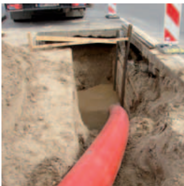
LHT® langzeittemperaturstabiles Schutzrohr zum Schutz von High Voltage Cables
