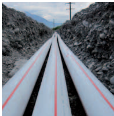
EMDS Schutzrohr in RC-Qualität – direkte Verlegung - sandbettlos
